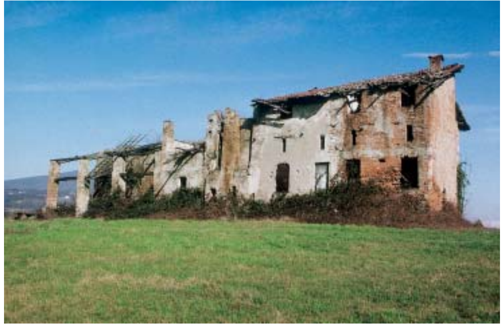
Masseria alla Motta in un'immagine recente (Foto I. Camponovo).
